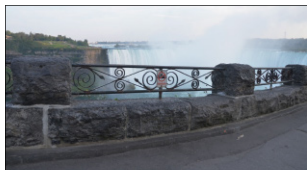
▲ 17-OOD-275 / Balustrade au-dessus des gorges du Niagara
