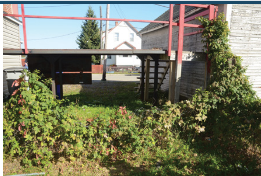
16-OCI-246 / Photo du lieu de l'incident
